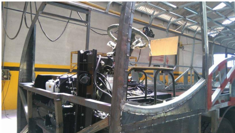
Figura 13. Revestimiento de las paredes
