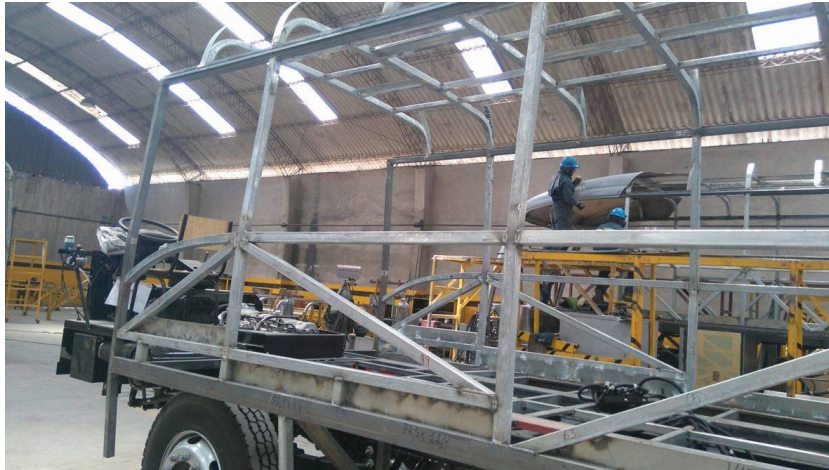
Figura 10. Unión del techo a las paredes.
