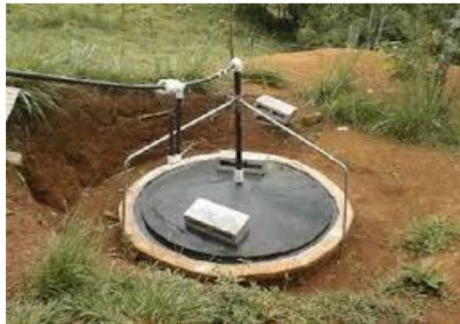
*Figura 24.* Biodigestor con restos agropecuarios
