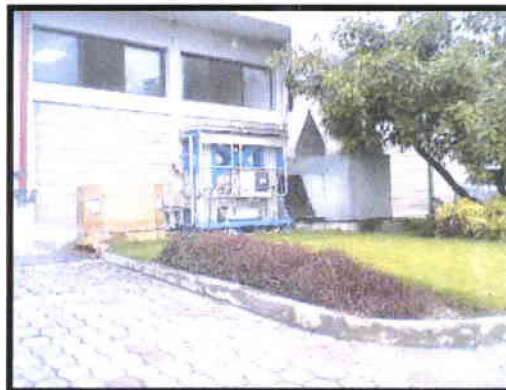
Fotos de la planta de tratamiento de aguas de la Empresa FERRERO Fuente: Autor
