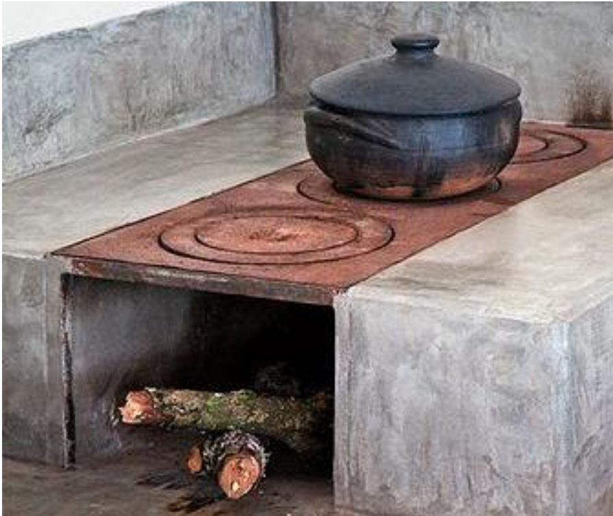
Figura 19. Estufa Justa sin codo Rocket.
