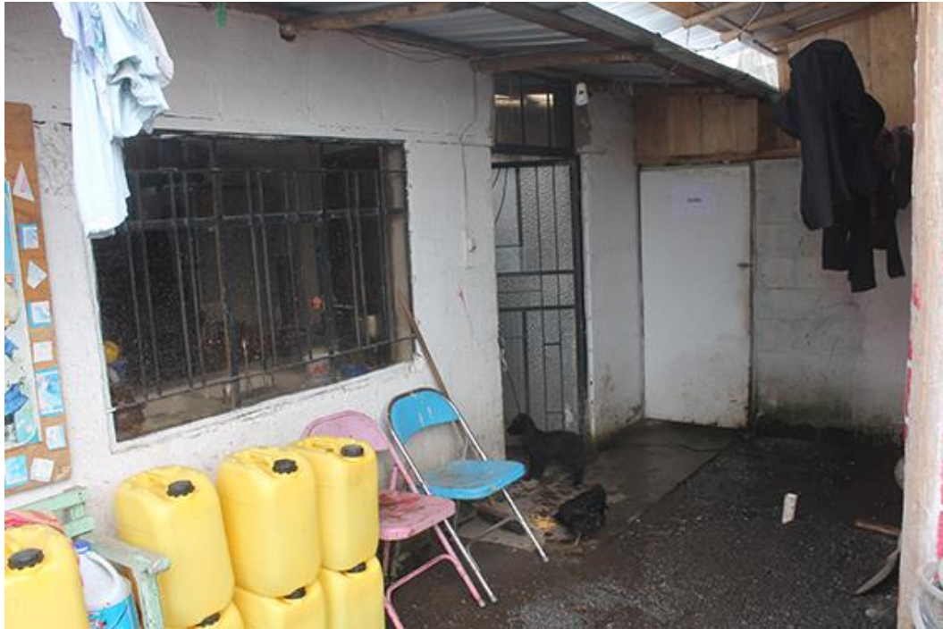
Figura 204. Instalaciones del Comedor Popular Jesús Peregrino, Entrada a la cocina y baño.
