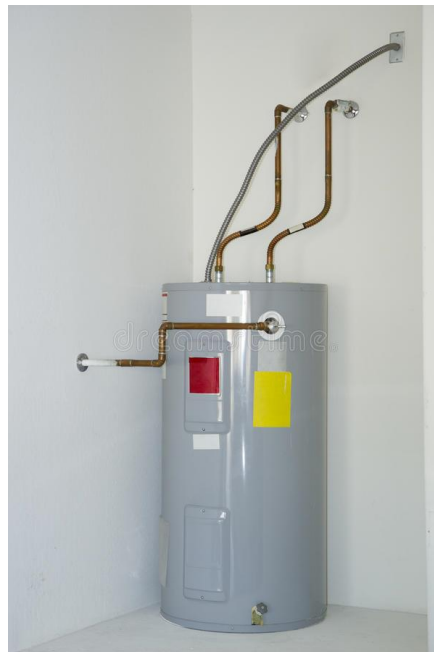
Figura 24. Tanque Calentador eléctrico.
