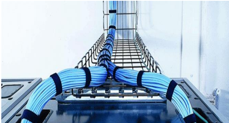
Figura 8. Tendido de Cable Tomado de (Cisco USA, 2017)
