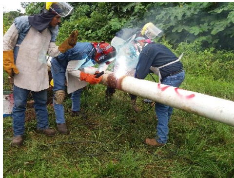
Figura 1. Mecánicos: soldadura especializada.
