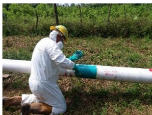
Figura 2. Revestimiento de tubería
