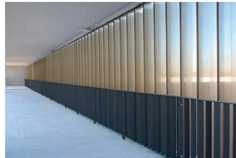
Figura 92. Quebravientos verticales motorizados
