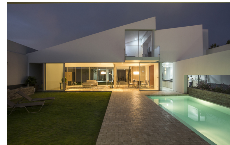
Figura 73. Fachada posterior Casa Patios
