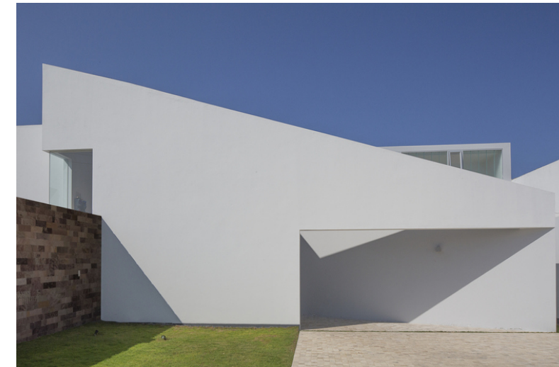
Figura 72. Fachada Casa Patios
