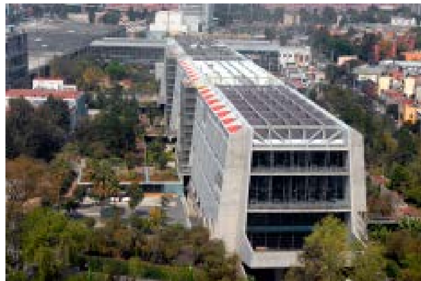
Figura 61. Vista aérea, Biblioteca Vasconcelos Tomado de: (Plataforma Arquitectura, s.f.)
