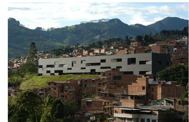
Fachada Sur Adaptado de: (Plataforma Arquitectura, s.f.)
