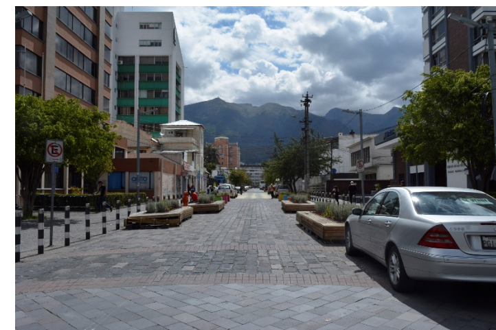
Figura 211. Plaza de los presidentes calle Jorge Washington vista hacia el oeste
