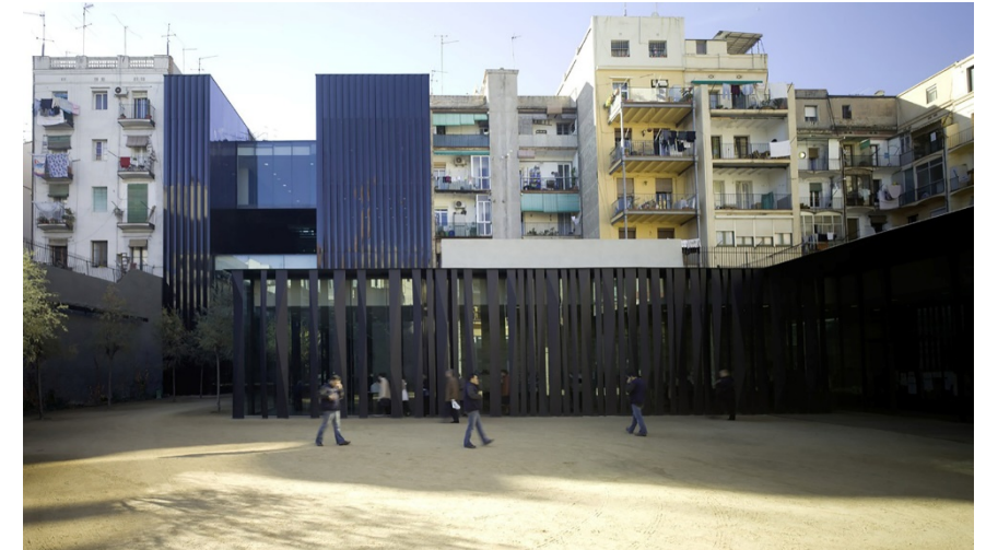
Figura 58. Patio interno, biblioteca Sant Antoni
