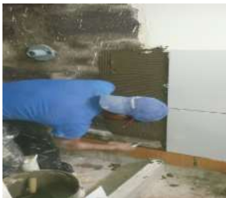
Figura 17. Caso práctico 1 Tomado de construcción Proyecto Conjuntos María Isabel, 2017
