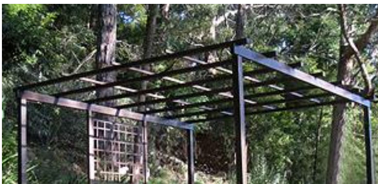
Figura 37. Vigas secundarias
