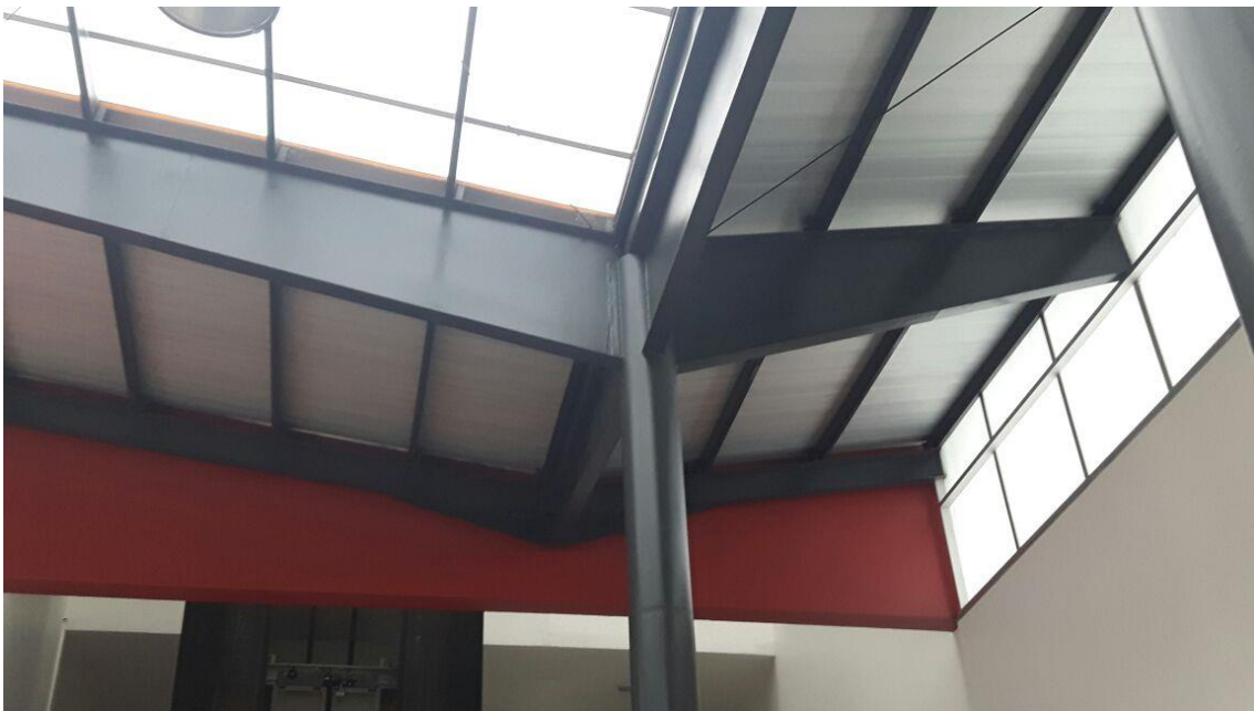
Figura 17 Estructura de acero
