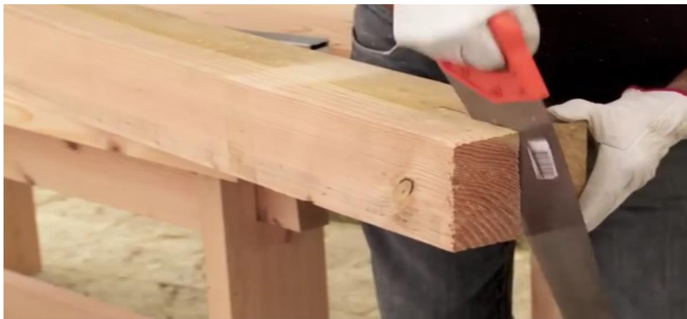
Figura 29 Preparación vigas principales
