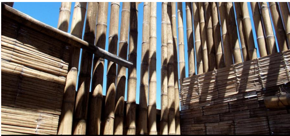
Figura 14 Estructura de bambú
