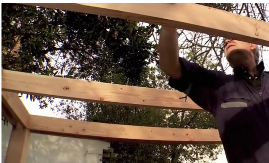
Figura 32 Armado de vigas secundarias
