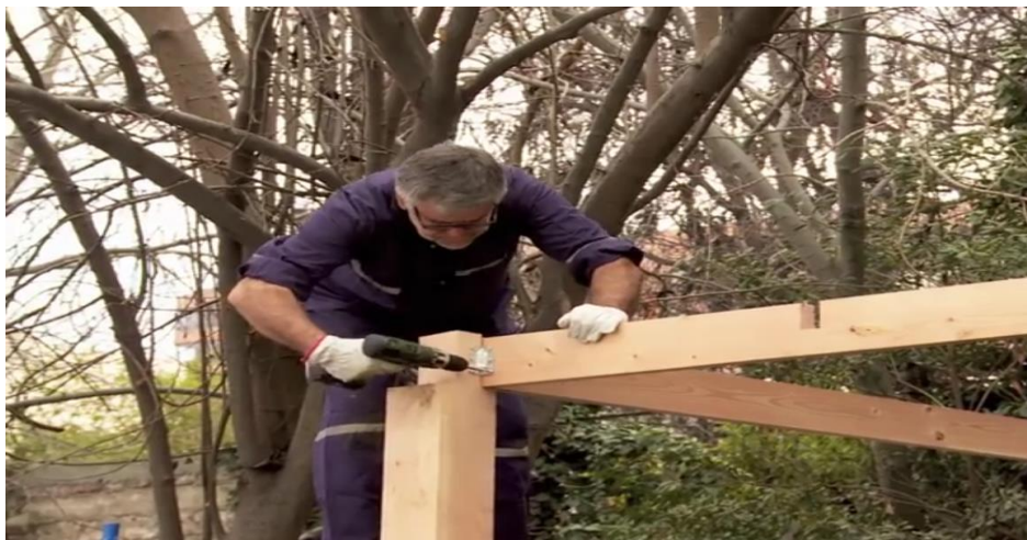
Figura 31 Armado de marco
