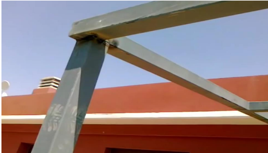
Figura 36 Vigas transversales acero
