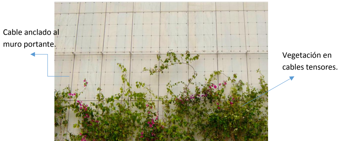
Figura 75: Diseño de cables con patrón ortogonal. Tomado de: Jakob AG Rope Systems
