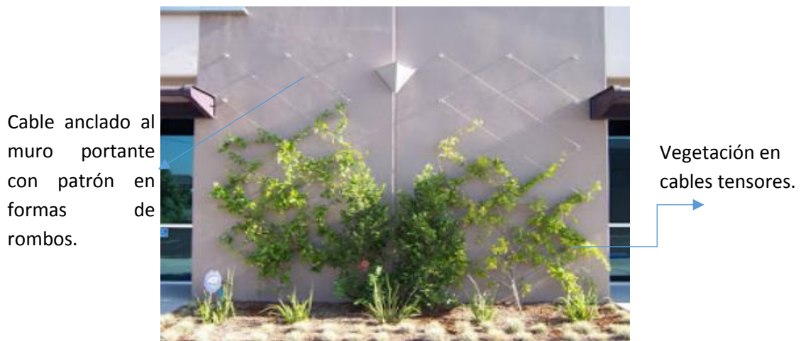
Figura 76: Diseño de cables con patrón en forma de rombos. Tomado de: Jakob AG Rope Systems
