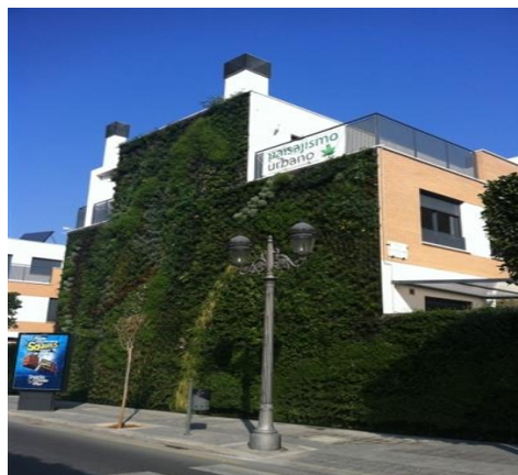
Figura 48: Complejo de bungalows en Paterna-España con aproximadamente 260 metros cuadrados de fachada verde. Tomado de: Paisajismo Urbano
