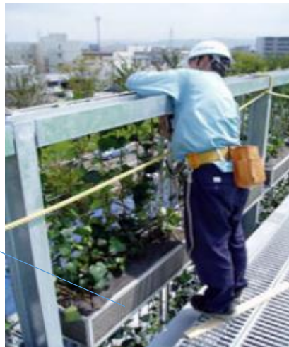
Figura 81: Instalación de un macetero flotante en la fachada Tomado de: GSKy Plant Systems
