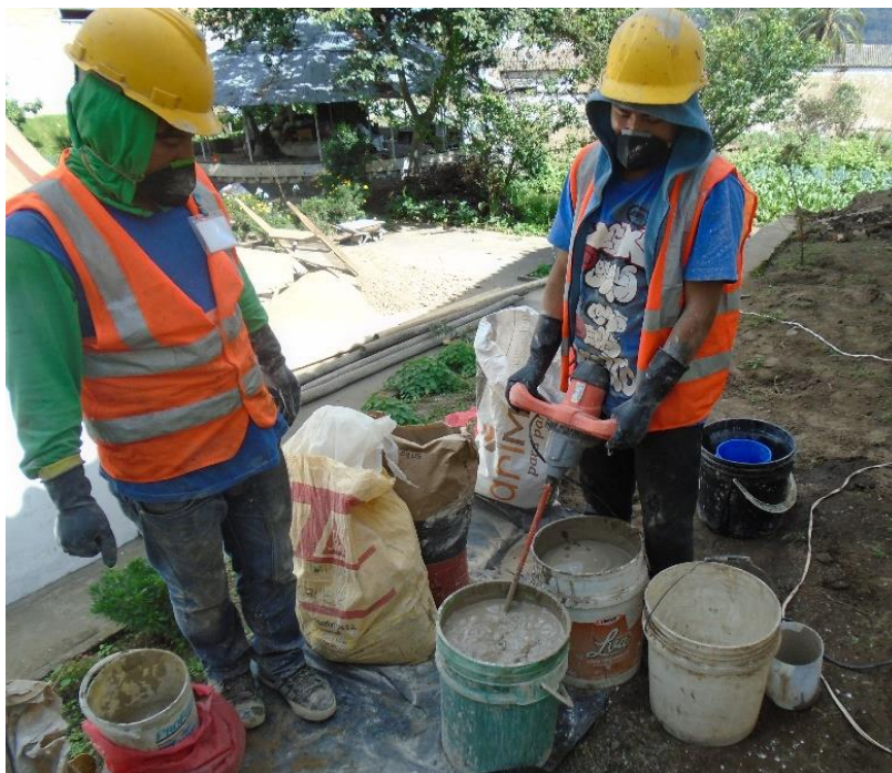
Figura 63. Preparación de mortero hidráulico de cal Convento Santa Clara - Tomado de: Diego Pichucho.
