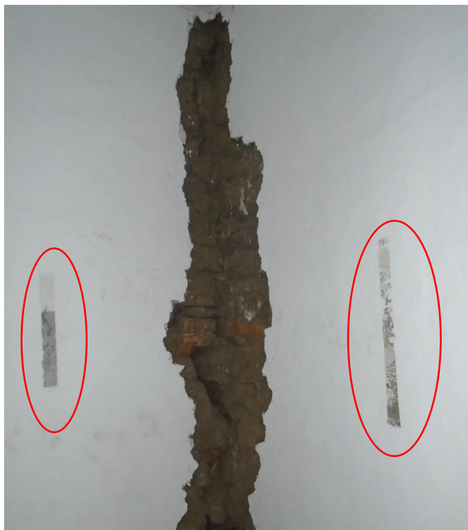
Figura 52. Calas de prospección de pintura mural, Claustro 1 – Sacristía. Esquina Noroeste Convento Santa Clara - Tomado de: Diego Pichucho.
