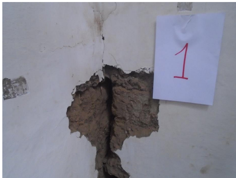
Figura 47. Cala de prospección 1, entre muro principal y muro secundario, Claustro 1 – Sacristía. Esquina Noreste Convento Santa Clara – Tomado de: Diego Pichucho
