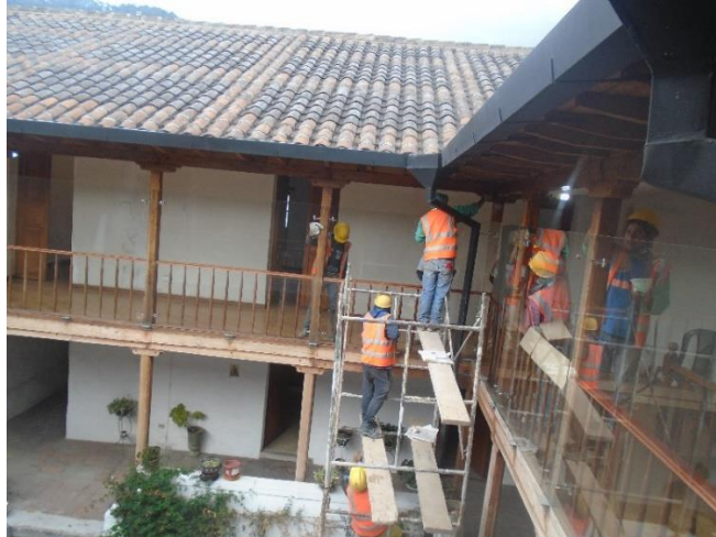
Figura 14. Mantenimiento de canales y bajantes de agua lluvia para la conservación de aleros de cubierta Convento Santa Clara - Tomado de: Diego Pichucho
