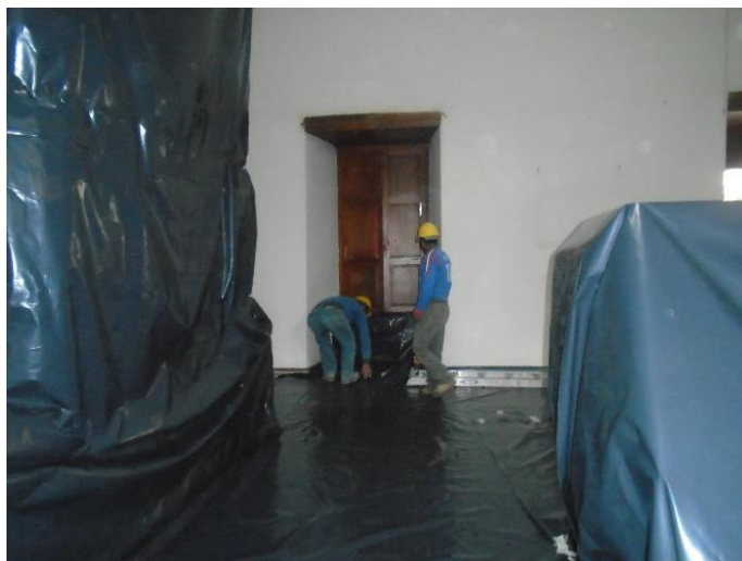
Figura 50. Protección con polietileno en lugares a intervenir Convento Santa Clara - Tomado de: Diego Pichucho.
