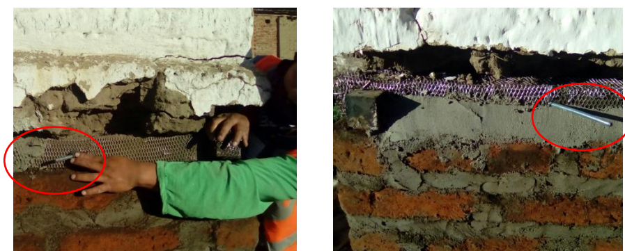
Figura 61. Reforzamiento con varillas roscadas ambos extremos Convento Santa Clara - Tomado de: Diego Pichucho.
