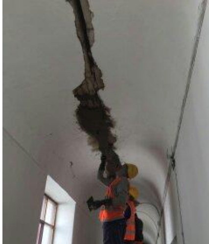
Figura 11. Resane de fisuras en bóveda principal La compañía. Tomado de: Diego Pichucho
