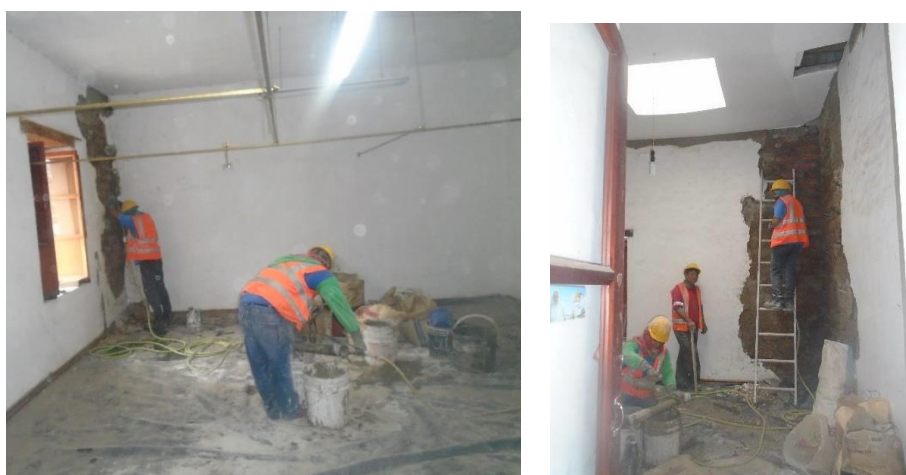
Figura 62. Inyecciones de reforzamiento en cosidos y llaves de madera Convento Santa Clara - Tomado de: Diego Pichucho.
