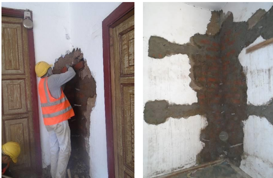
Figura 56. Descosido de mampostería de adobe y cosido de mampostería de ladrillo Convento Santa Clara - Tomado de: Diego Pichucho.
