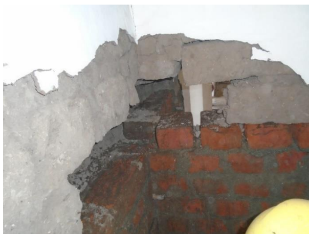
Figura 57. Trabe de mampostería de ladrillo entre muro principal y muro secundario Convento Santa Clara - Tomado de: Diego Pichucho.
