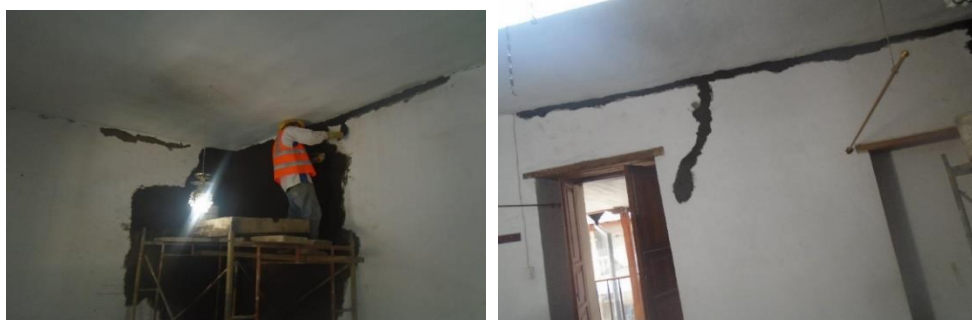
Figura 65. Resane de fisuras de cielo falso, en base a cal, cemento y barro, paletado con guante, para acabado brumoso Convento Santa Clara - Tomado de: Diego Pichucho.
