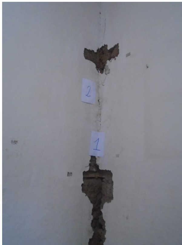
Figura 48. Cala de prospección 1 y 2 entre muro principal y muro secundario, Claustro 1 – Sacristía. Esquina Noroeste Convento Santa Clara - Tomado de: Diego Pichucho.
