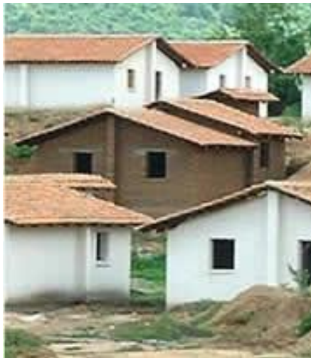
Figura 34. Construcciones con adobe y revestidas con APV - Tomado de: La Web (Wikipedia).
