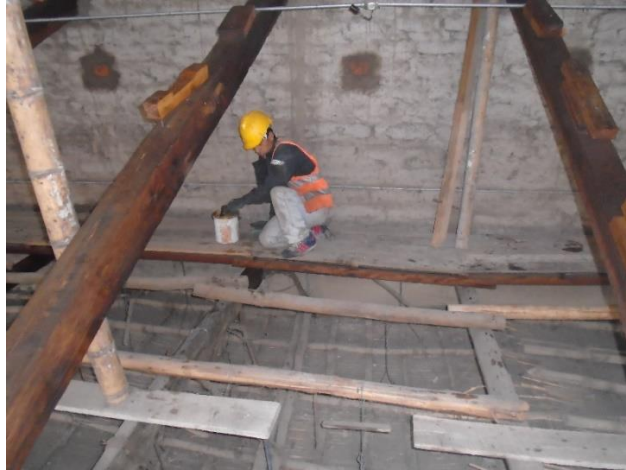
Figura 13. Preservación de cerchas de madera con preservante kimocide en cubierta convento Santa Clara. - Tomado de: Diego Pichucho
