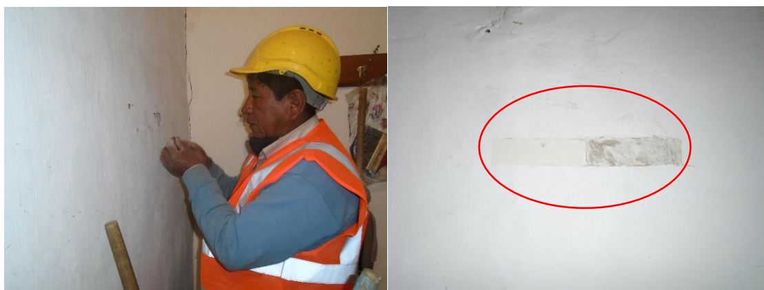
Figura 51. Calas de prospección de pintura mural, en sitios de intervención Convento Santa Clara - Tomado de: Diego Pichucho.
