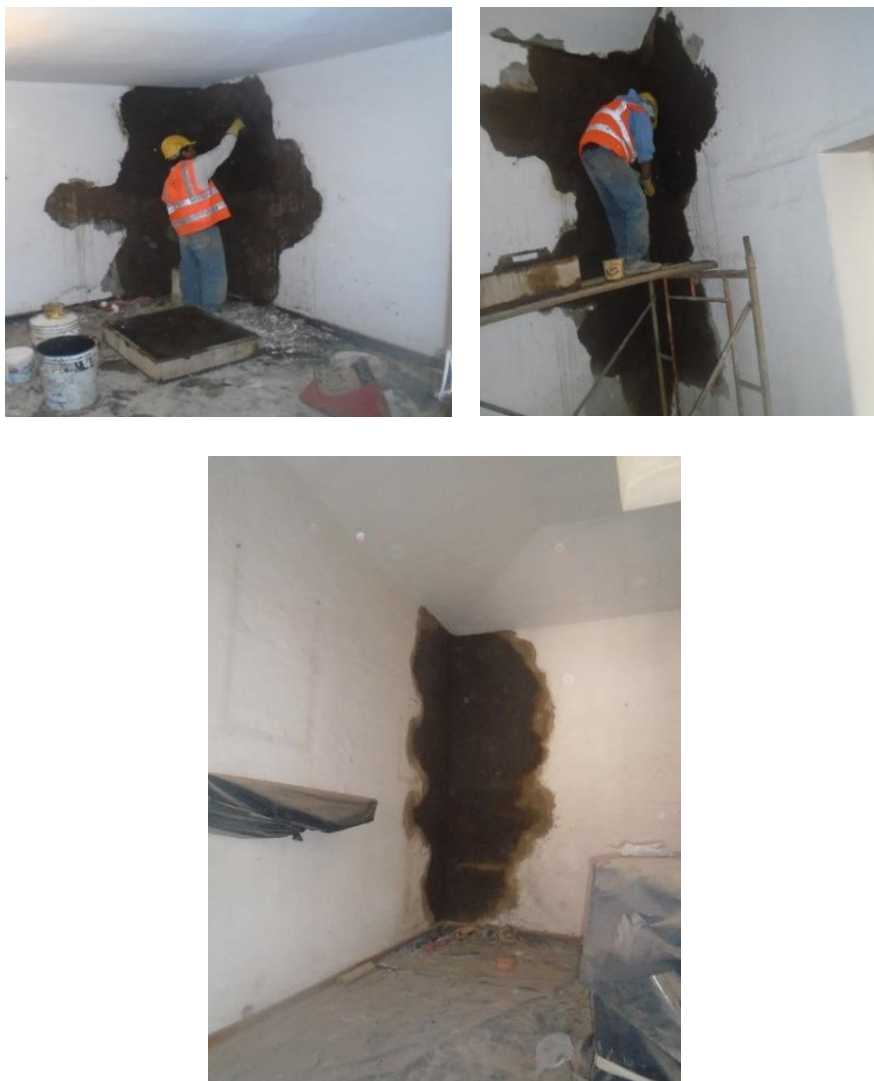
Figura 64. Enlucido en base a cal, cemento y barro, paleteado con guante, para acabado brumoso Convento Santa Clara - Tomado de: Diego Pichucho.
