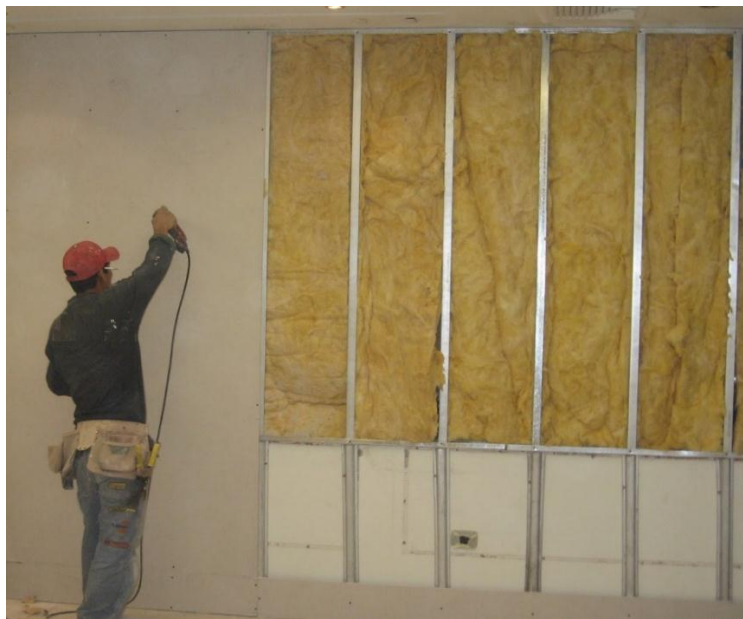
Figura 17. Armado mampostería de gypsum con lana de vidrio
