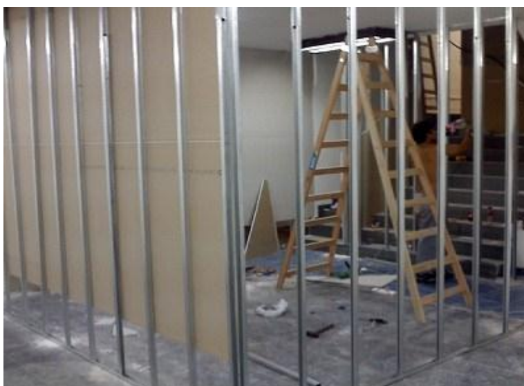
Figura 1. Sistema constructivo liviano en gypsum
