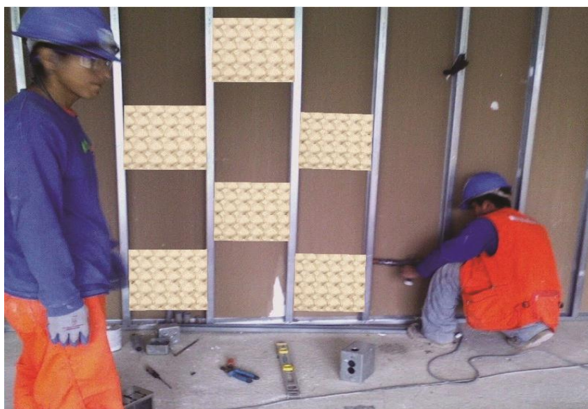
Figura 18. Cubetas de huevos en una mampostería de gypsum
