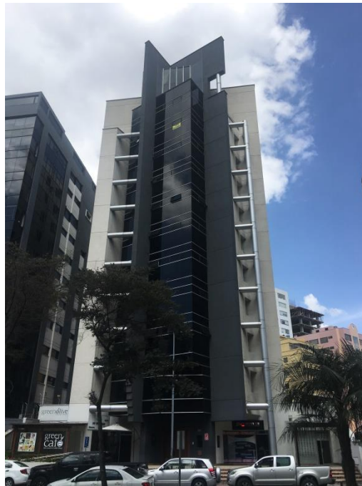
Figura 63. Localización de la edificación, Fachada Principal.
