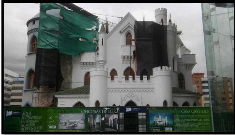
Figura 62. Proceso de restauración de fachada, 2016.
