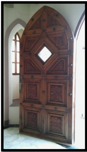
Figura 37. Puerta de ingreso principal.
