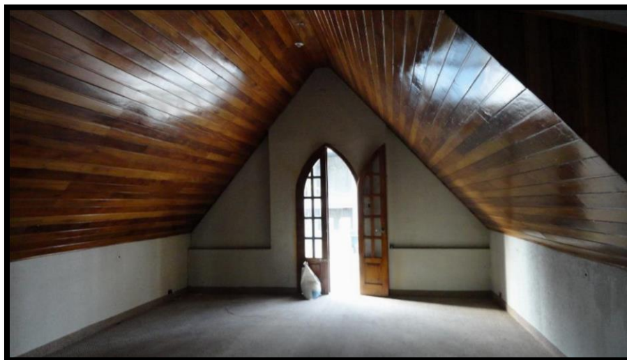
Figura 10. Vista interior, habitación de cuarto piso.
