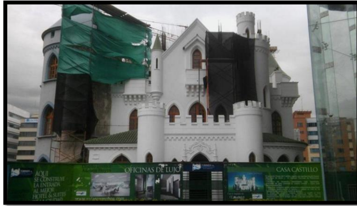
Figura 3. Vista frontal actual.
