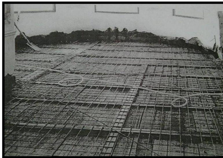
Figura 60. Registro fotográfico de intervención a castillo Larrea.
