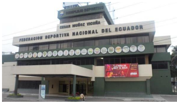
Figura 10. Instalaciones de Fedenador en la actualidad
