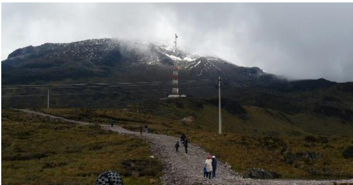
Figura 11. Torre existente ladera noroeste.
