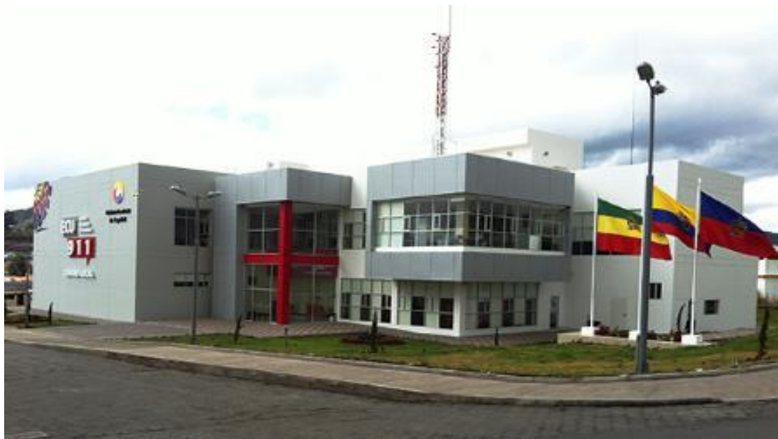
Figura 16. Torre del ECU 911 Tulcán
