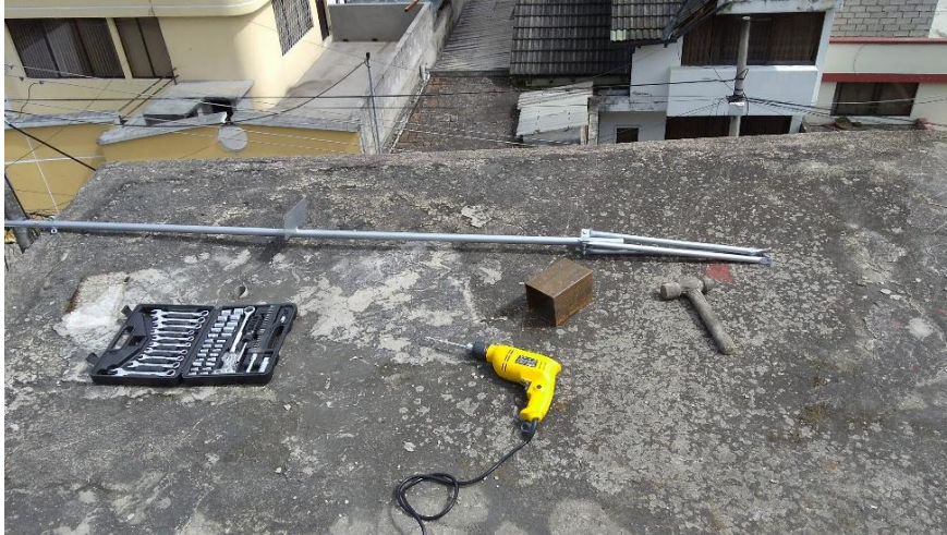
Figura 87. Ensamblaje trípode sección 1
