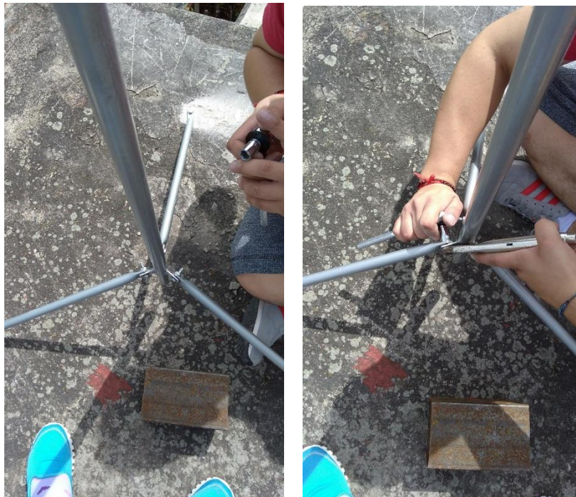
Figura 88. Fijación patas del trípode al piso.
