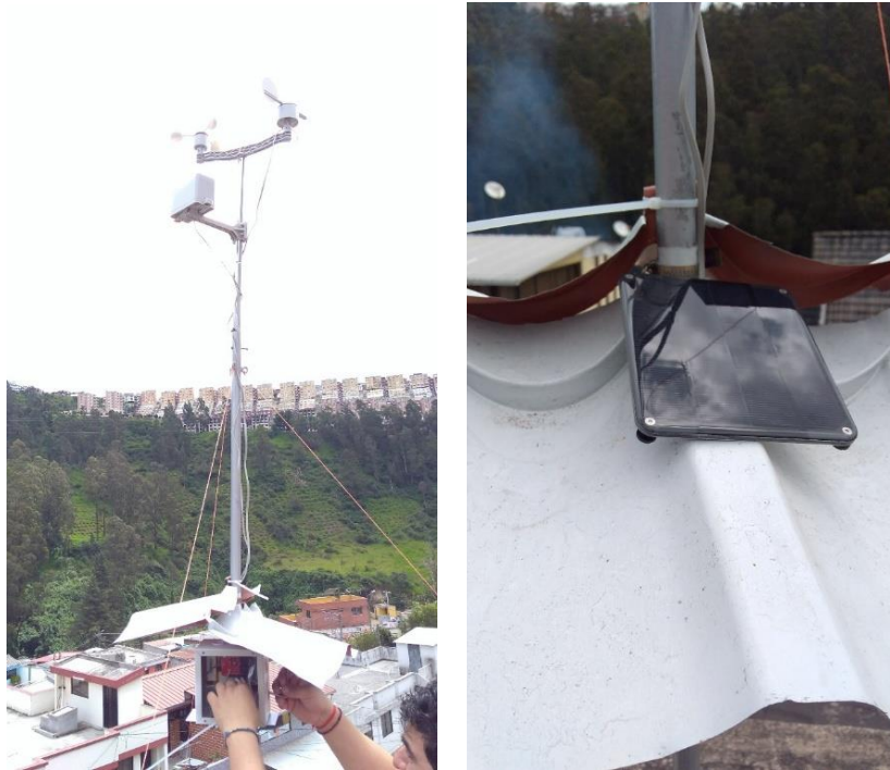
Figura 93. Instalación de panel solar
