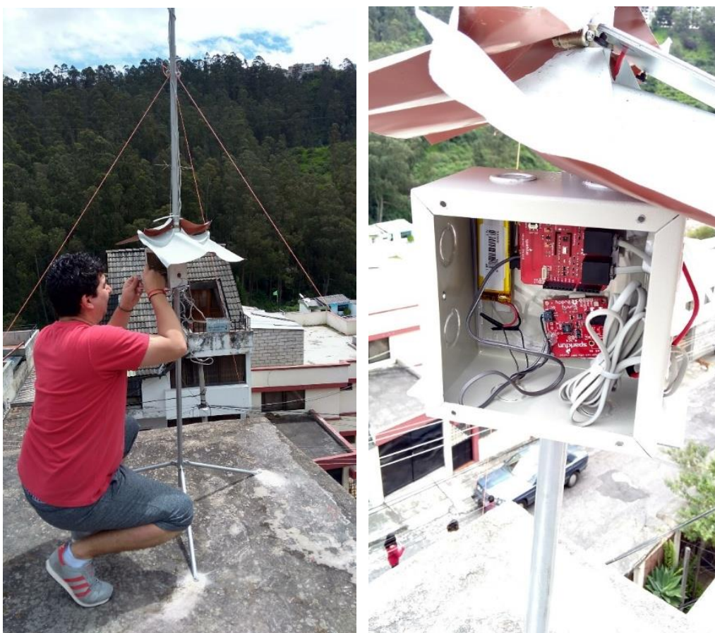
Figura 92. Montaje equipos activos y techo de protección solar
