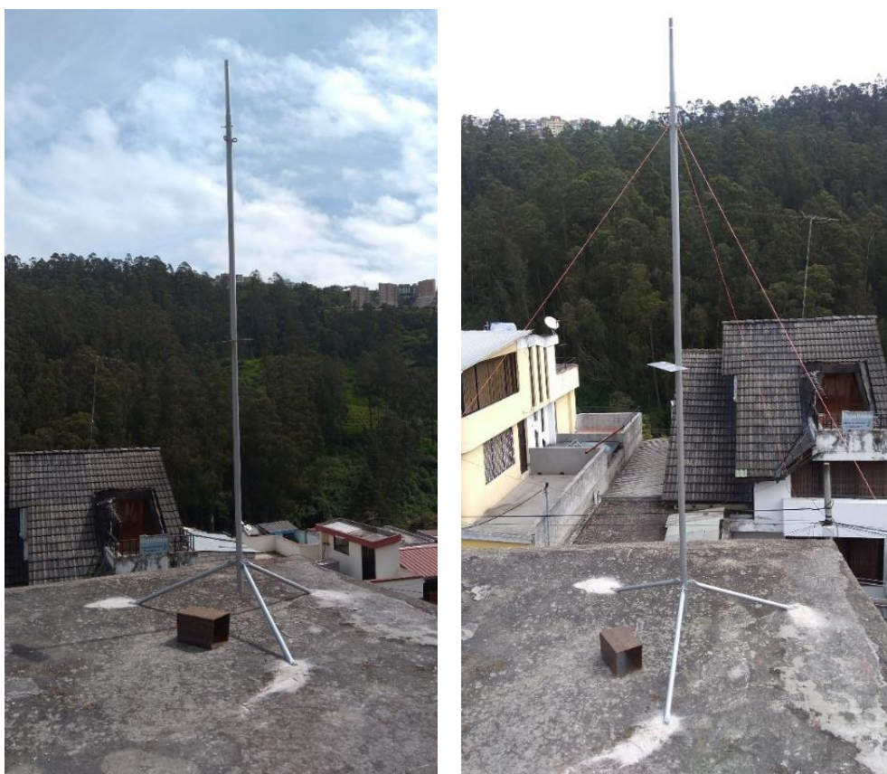
Figura 89. Fijación trípode y puesta de tensores
