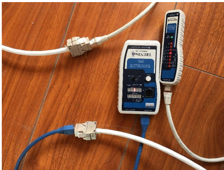
Figura 43. Pruebas de continuidad Etiquetado del cable
