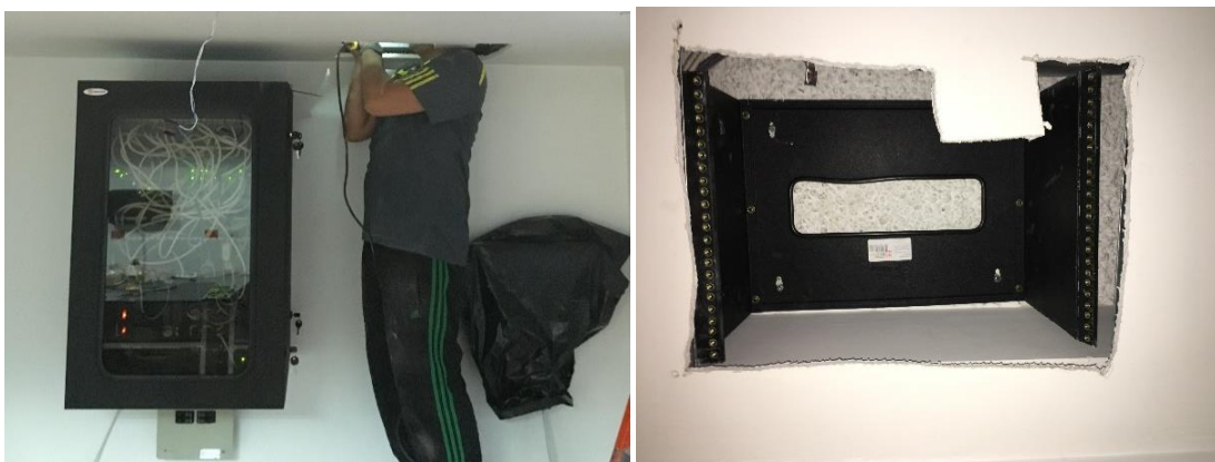
Figura 40. Instalación del soporte de pared para el punto de control
