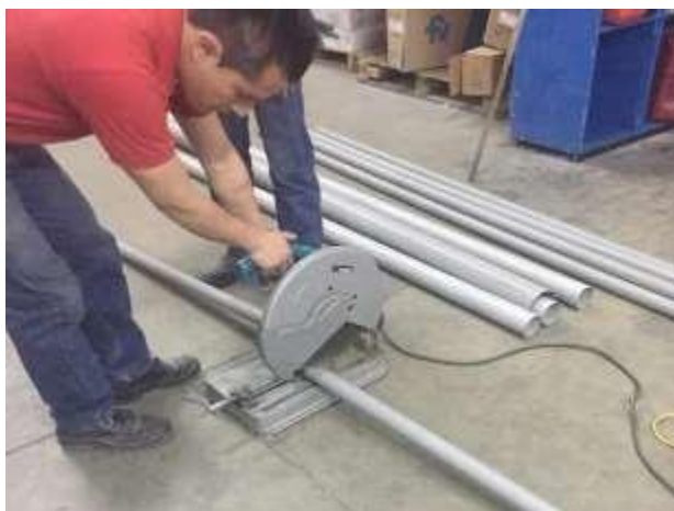
Figura 63. Corte de tubos de PVC.
