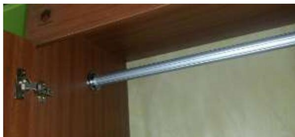
**Figura 37.** Tubo para armador de aluminio
