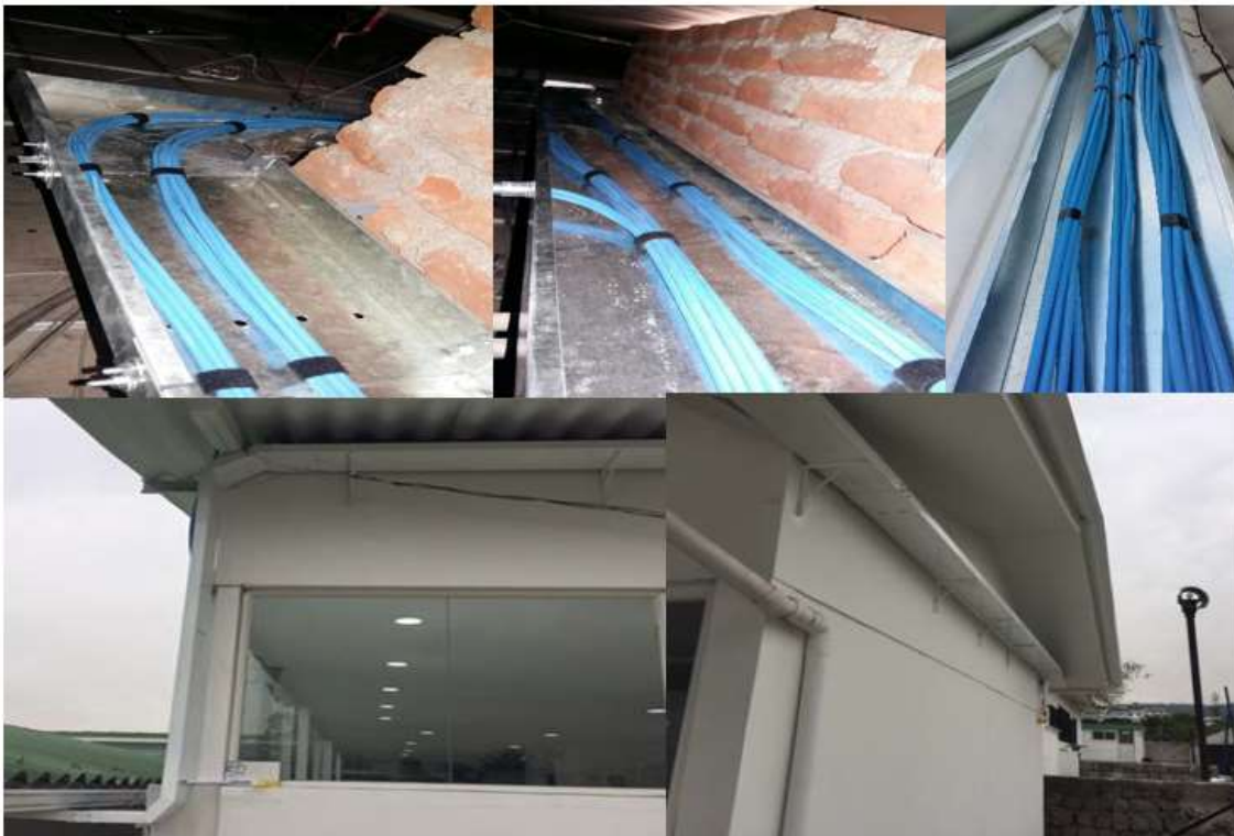
Figura 33. Implementación de la canalización del CAA Batán
