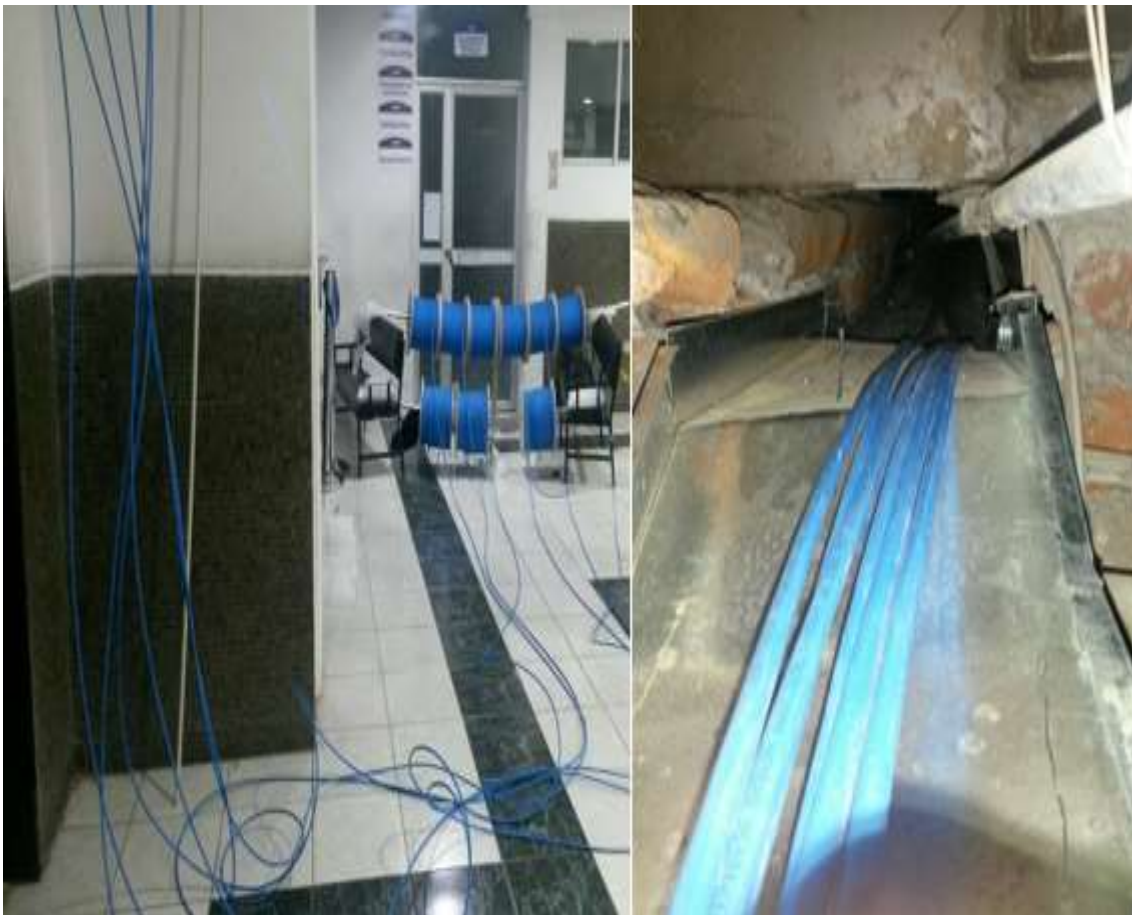
Figura 34. Implementación del cableado horizontal y vertical
