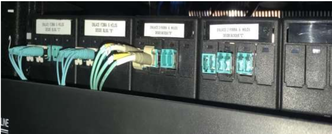
Figura 35. Fusión y ordenamiento de los hilos de fibra óptica
