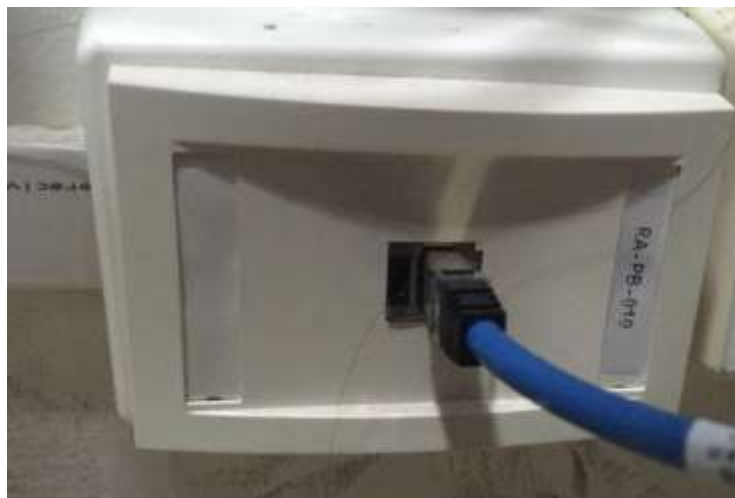
Figura 37. Implementación de puntos de conexión terminales.
