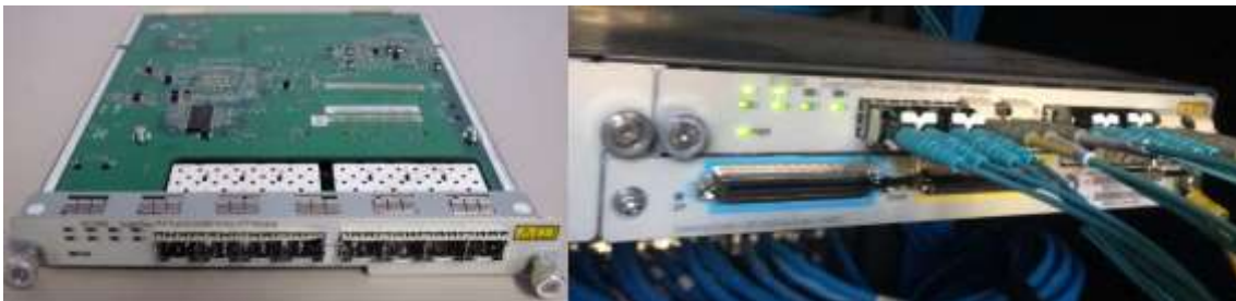
Figura 75. Instalación módulo de fibra en switch de core.
