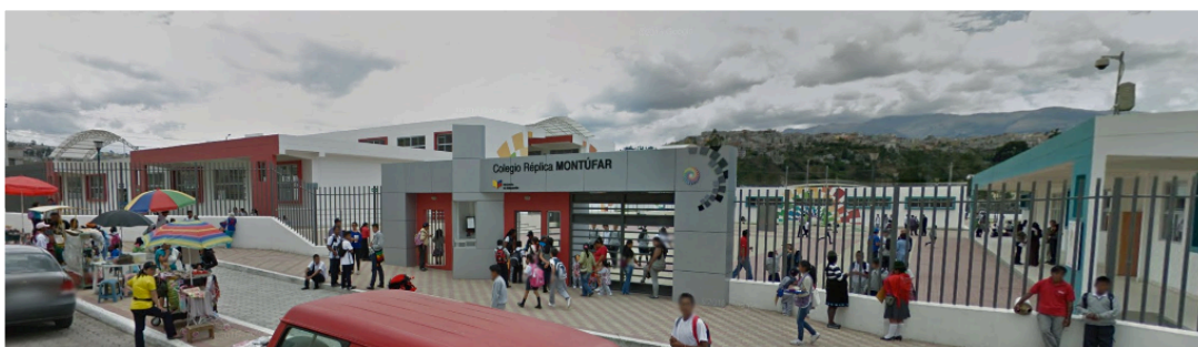
Figura 10. Entrada principal del Colegio “Réplica Montúfar”.
