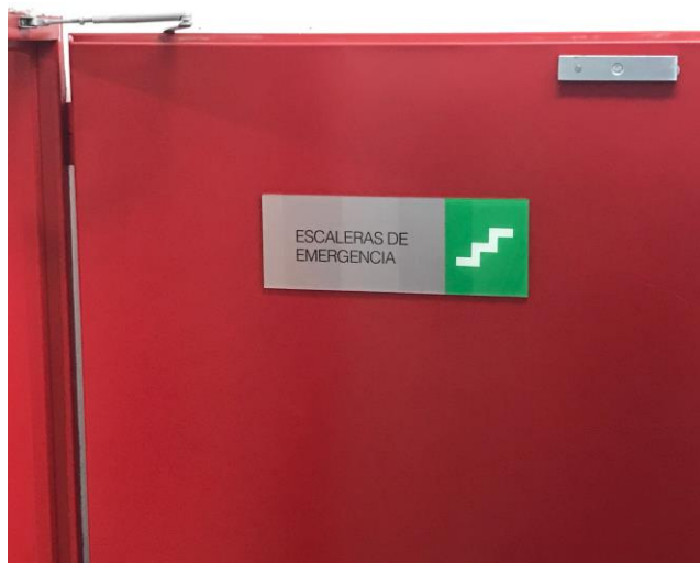
Figura 50. Señalética Escalera de Emergencia
