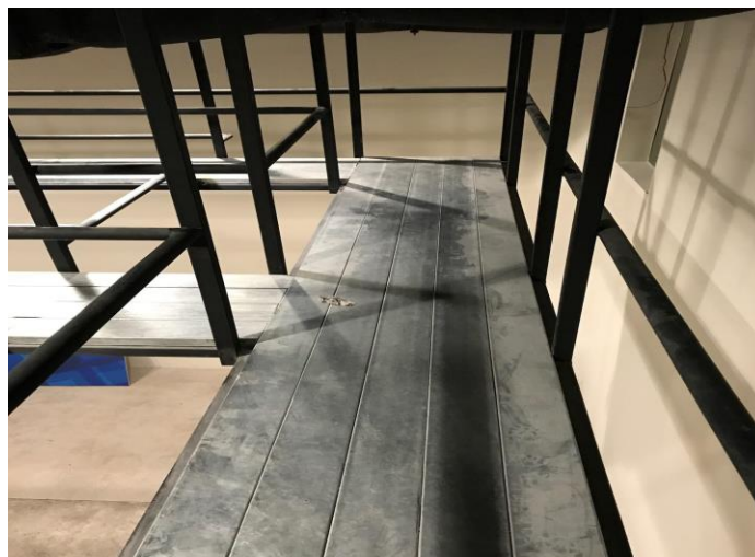
Figura 20. Pasos de gato o puente de iluminación
