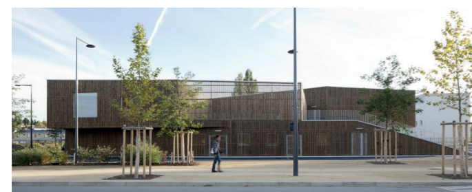
Figura 82. Fachada Lateral Tomado de (Arqa, 2013)
