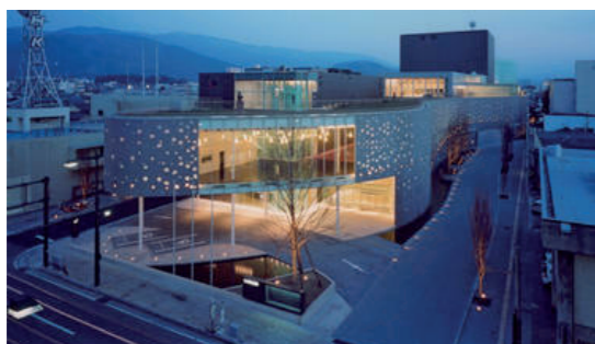
Figura 78. Acceso principal Tomado de (Architectuul, s.f.)
