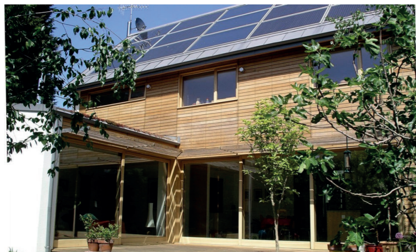
Figura 92. Paneles solares en cubierta
