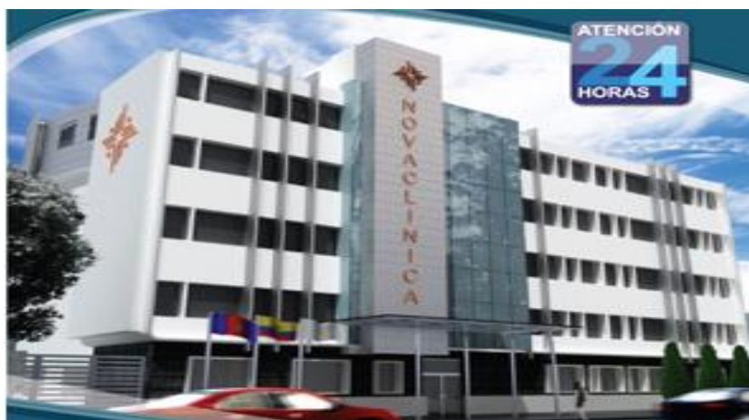
Figura 8. Instalaciones de Novaclínica S.A. Tomado de Novaclínica (2016)
