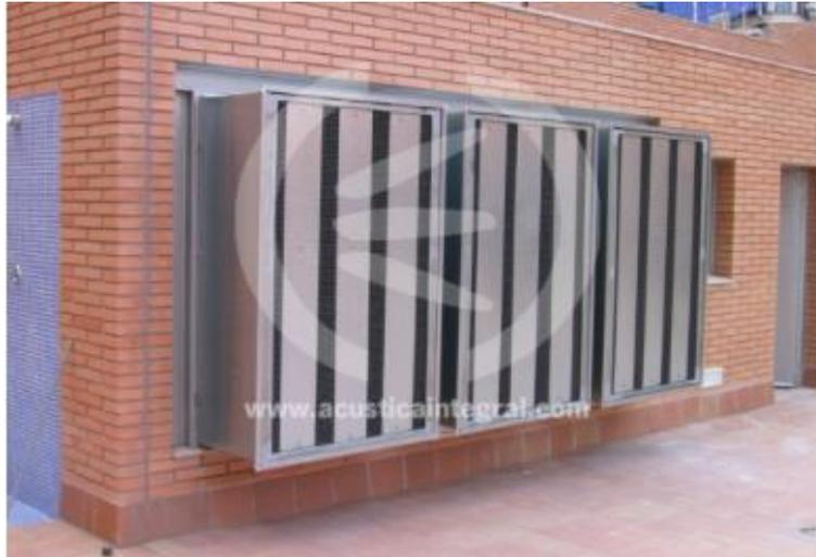
*Figura 44.* Silenciador acústico de celdillas
