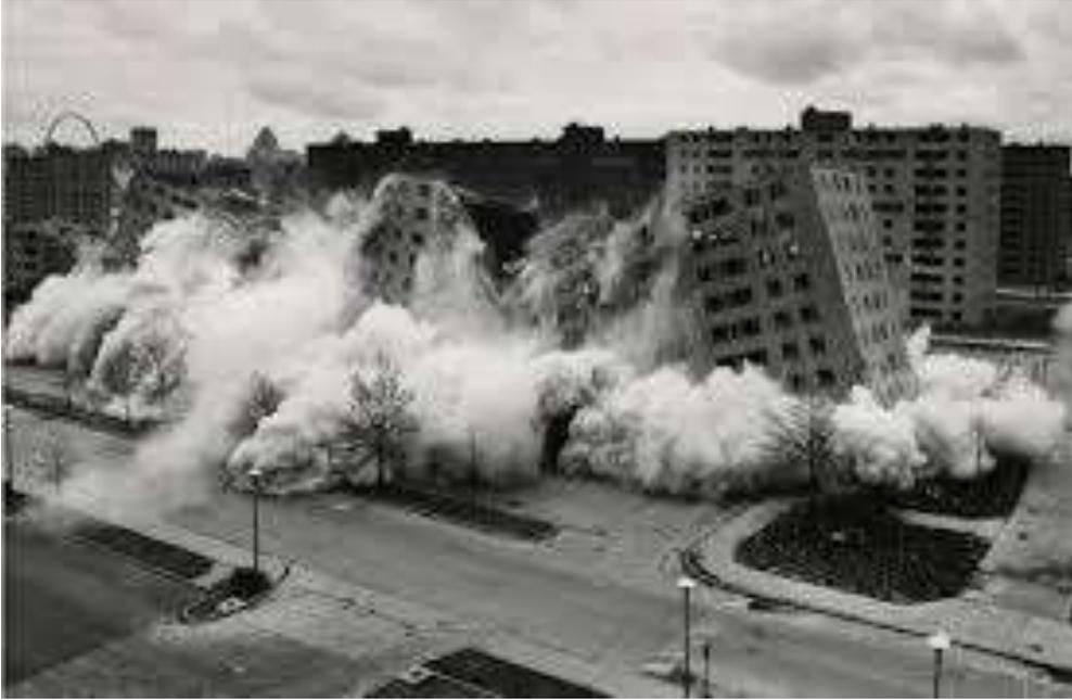
Figura 1. Demolición con explosivos del primer edificio de Pruitt Igoe.
