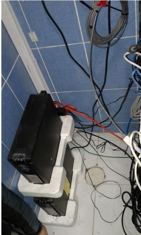
Figura 13. UPS en mal estado
