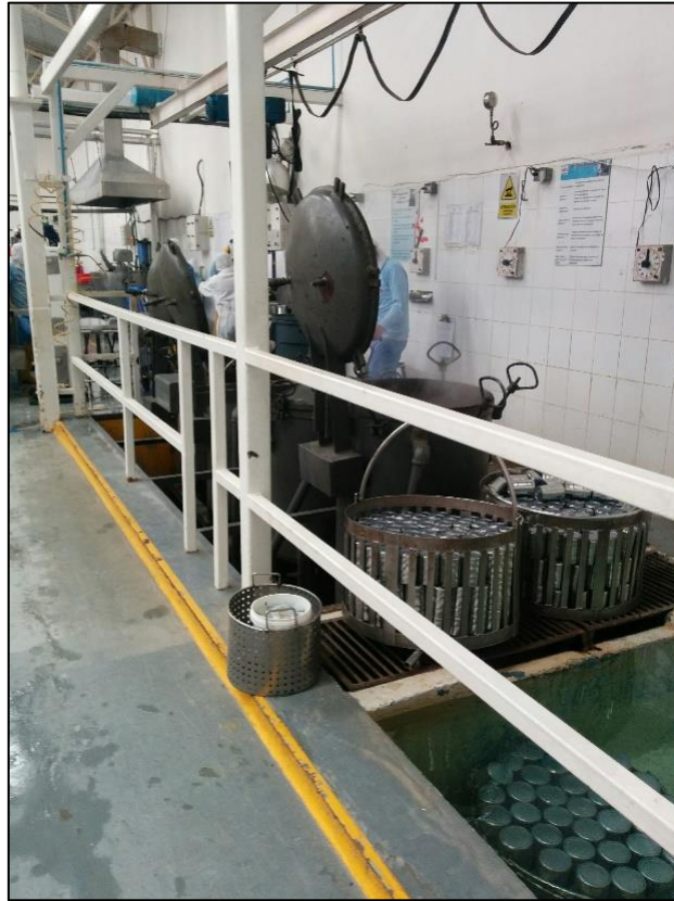
Figura 21. Esterilizado y Enfriado.
