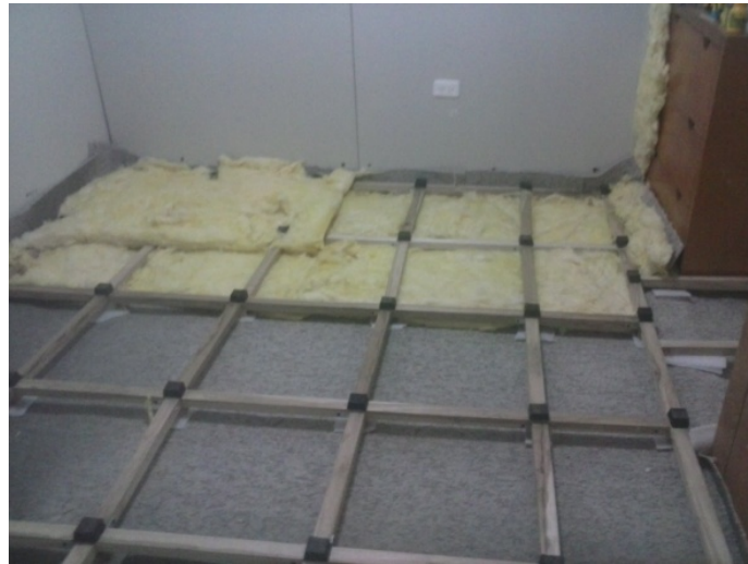
Figura 49. Detalle de relleno de estructura mediante lana de vidrio.
