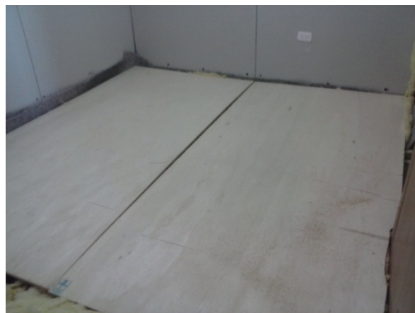
Figura 50. Colocación de tabla triplex de 18mm como piso falso
