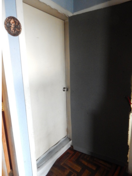
Figura 51. Detalle de ingreso mediante puertas dobles.
