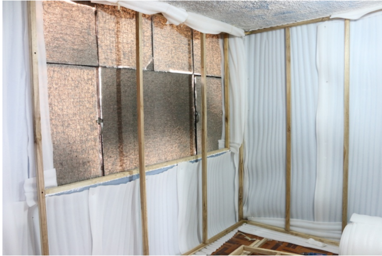
Figura 44. Detalle de estructuras y revestimiento de paredes.
