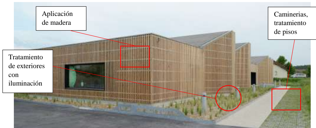
Figura 32. Exterior centro de salud
