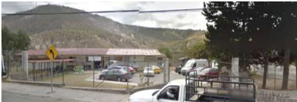
Figura 4. Estado actual del Centro de Salud.
