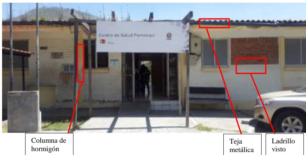
Figura 5. Fachada frontal Centro de Salud.
