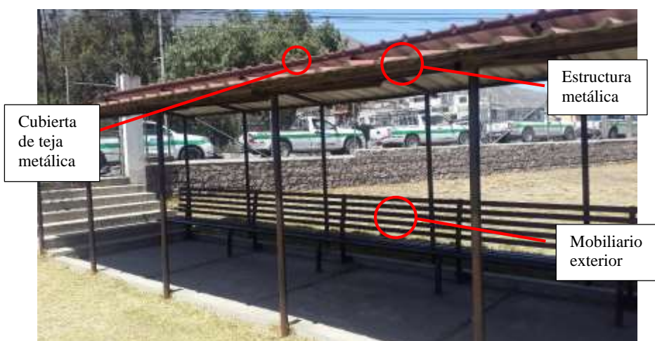
Figura 6. Área exterior Centro de Salud.
