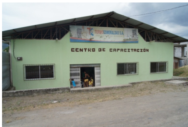
Figura 14. Centro de Capacitación Comunitaria de Termoesmeraldas.
