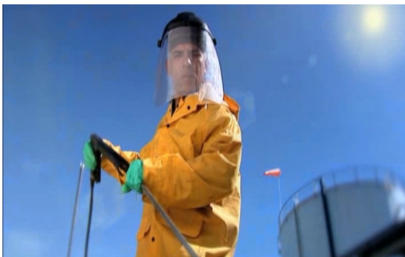
Figura 8. Equipo para limpieza de intercambiadores de calor.
