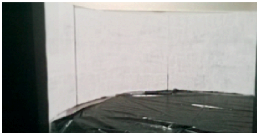
Figura 31. Modulares después de tres manos de pintura y plástico colocado como base para alfombra.
