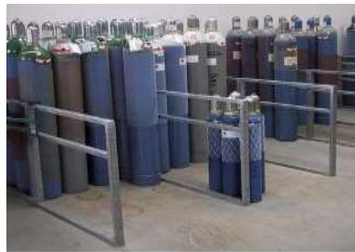
Cilindros almacenados a nivel de piso con barras de seguridad
