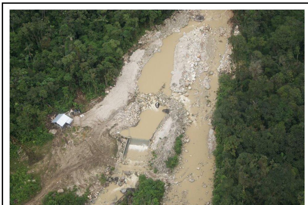
Figura # 1: DESLAVE EN LA CORDILLERA QUE OCACIONÓ LA SUSPENSIÓN DEL SERVICIO
