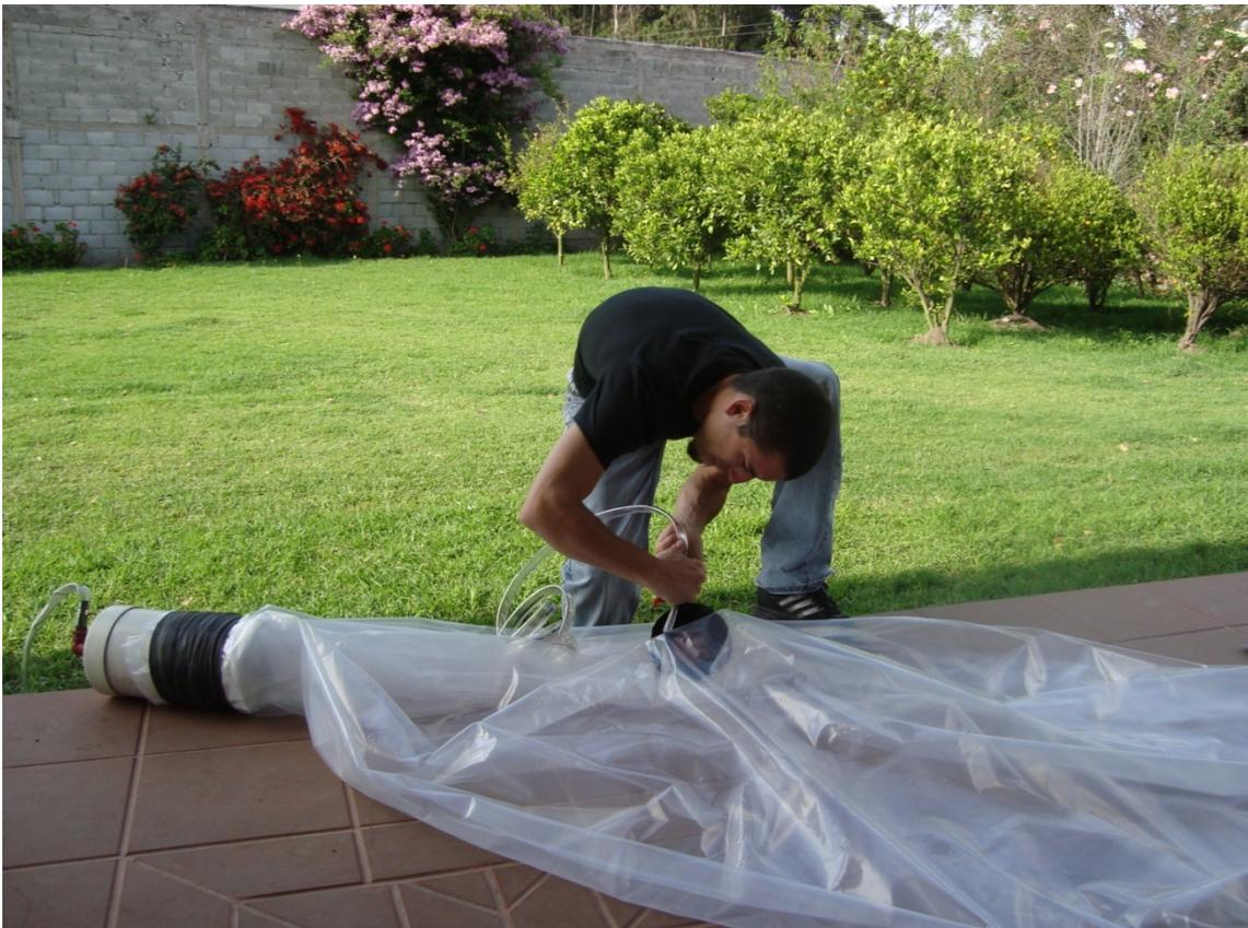
**Anexo N° 5:** FOTOS DE LA CONSTRUCCIÓN DEL PROTOTIPO DEL BIODIGESTOR. Biodigestor terminado.
