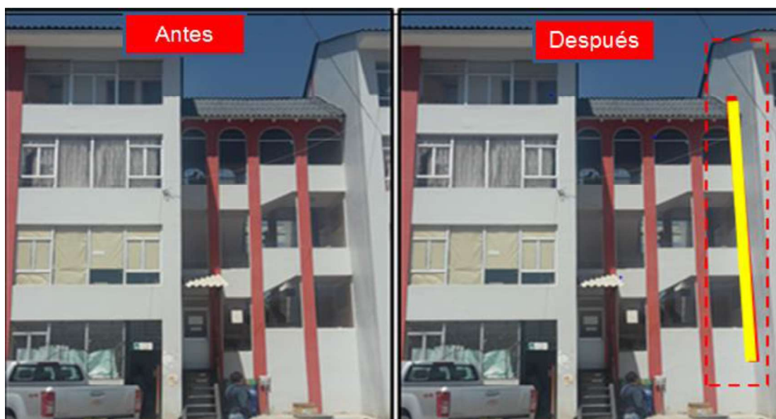
Figura 57. Backbone de FO exterior del edificio.
