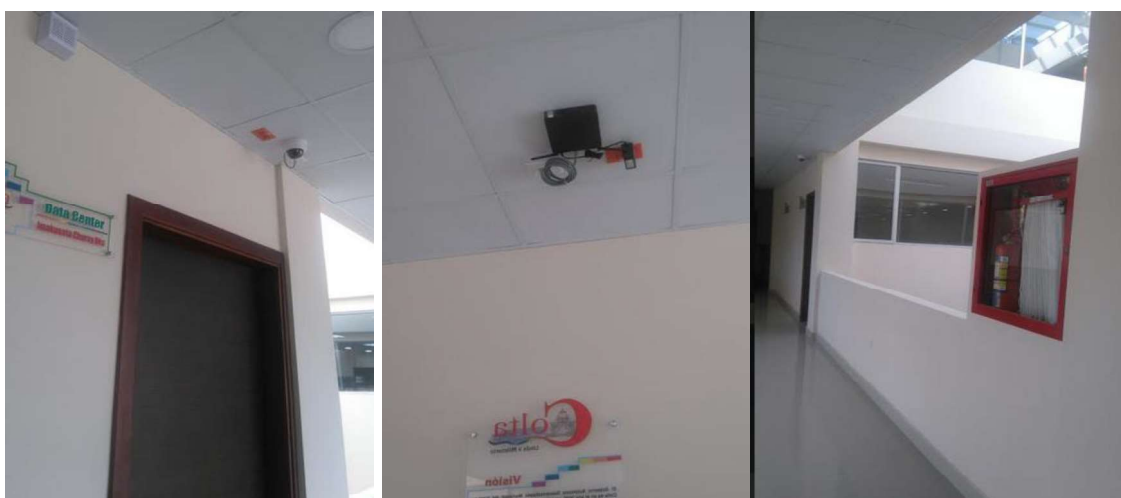
Figura 29. Instalaciones nuevas del GAD de Colta.
