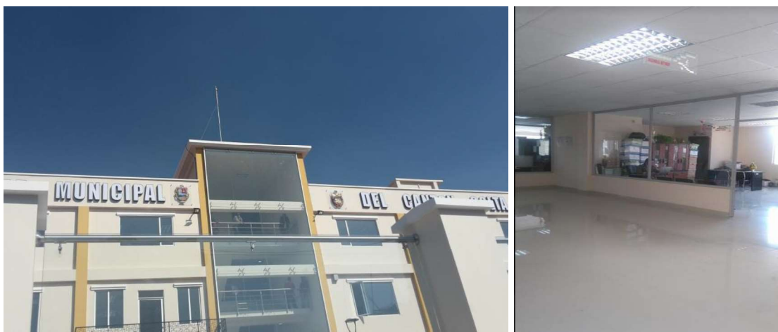
Figura 28. Instalaciones nuevas del GAD de Colta.
