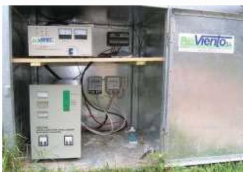
*Figura 29.* Controlador de carga eólica /solar
