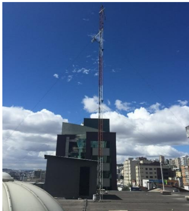
Figura 77. Torre y caseta de telecomunicaciones en las oficinas de SLB.
