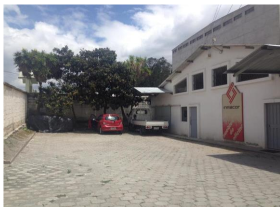
Figura 6. Parqueadero de la edificación. Exterior galpones Inmacor.
