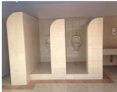
Figura 12. Baños para empleados. Exterior galpones.
