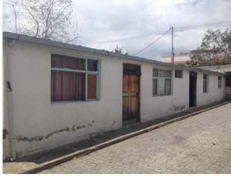
Figura 11. Fachada vivienda guardianía. Exterior galpones.
