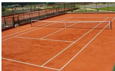
Figura 18. Canchas de polvo de ladrillo.
