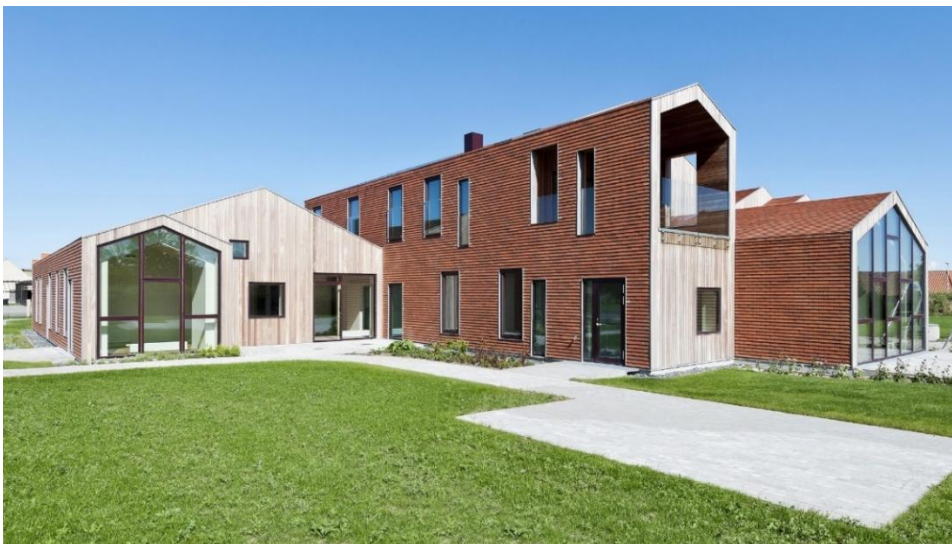
Figura 24. Interior del Hogar de menores Cebra Tomado de (Plataforma de arquitectura, 2014)
