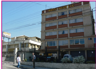
Figura 73. Exterior del Edificio Hotel Majestic
