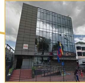
Figura 79. Exterior del Edificio Empresa Publica Metropolitana de Movilidad y Obras Publicas
