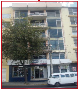
Figura 77. Edificio a Intervenir
