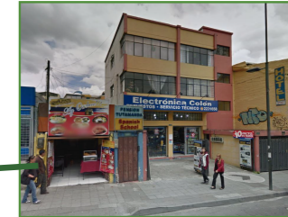
Figura 78. Exterior del Edificio Cristobal Colon Spanish School
