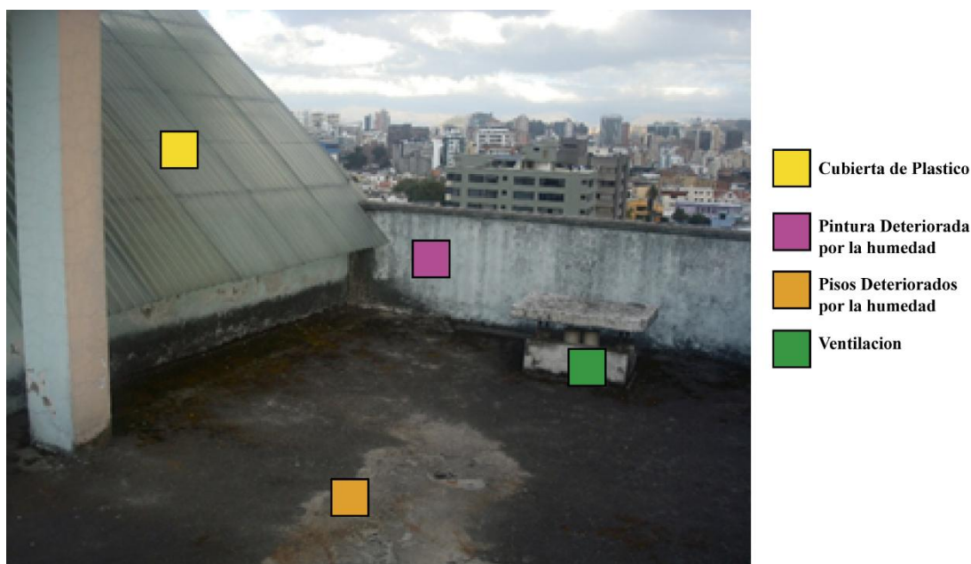
Figura 66. Interior del Edificio
