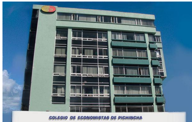
Figura 88. Fachada del CEP
