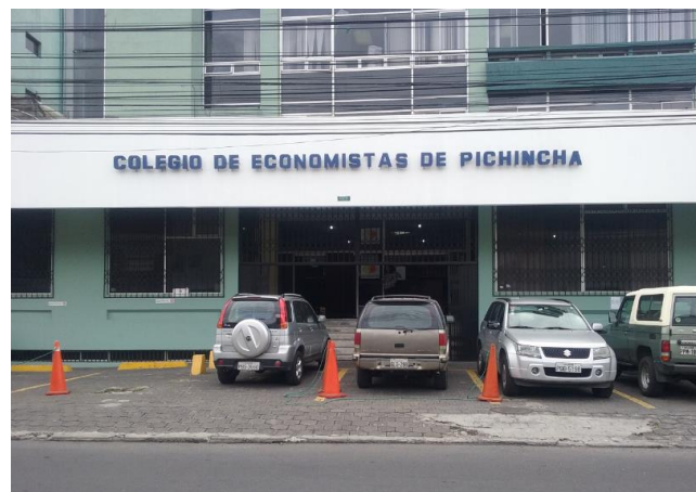
Figura 5. Fachada principal de la edificación
