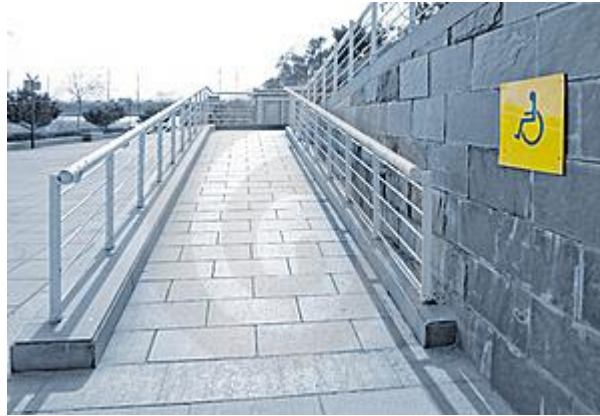
Figura 36. Uso de rampas para PMR
