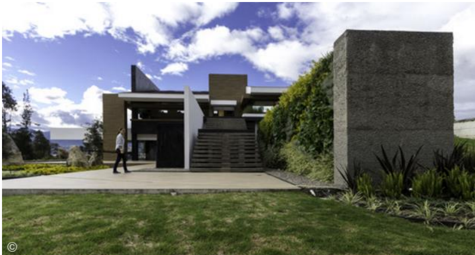
Figura 59. Fachada principal de Oficinas Covalco Tomado de: Plataforma arquitectura Ecuador. (2015)
