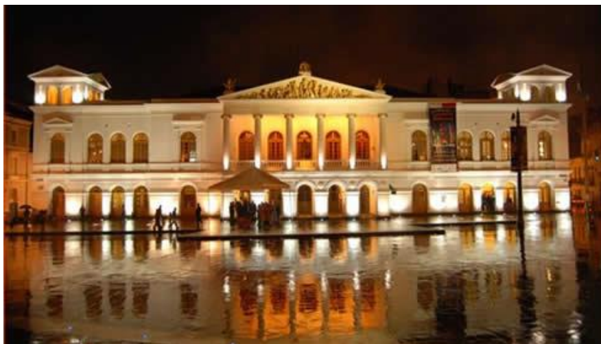
Figura 29. Fachada Exterior restaurante Theatrum
