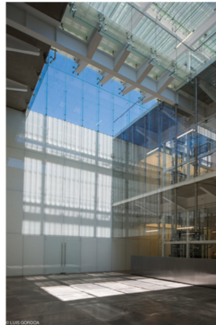
Figura 105. Estructura moderna. Tomado de (plataformaarquitectura, 2012)
