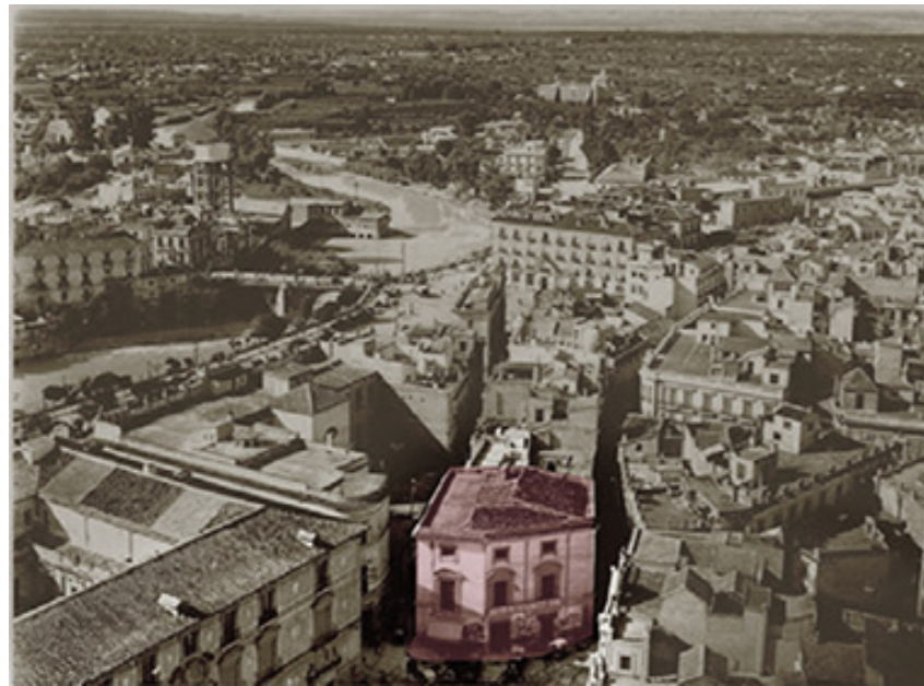
Figura 11. Antigua casa barroca antes de ser demolida. Tomado de (arquimaster, 2014)
