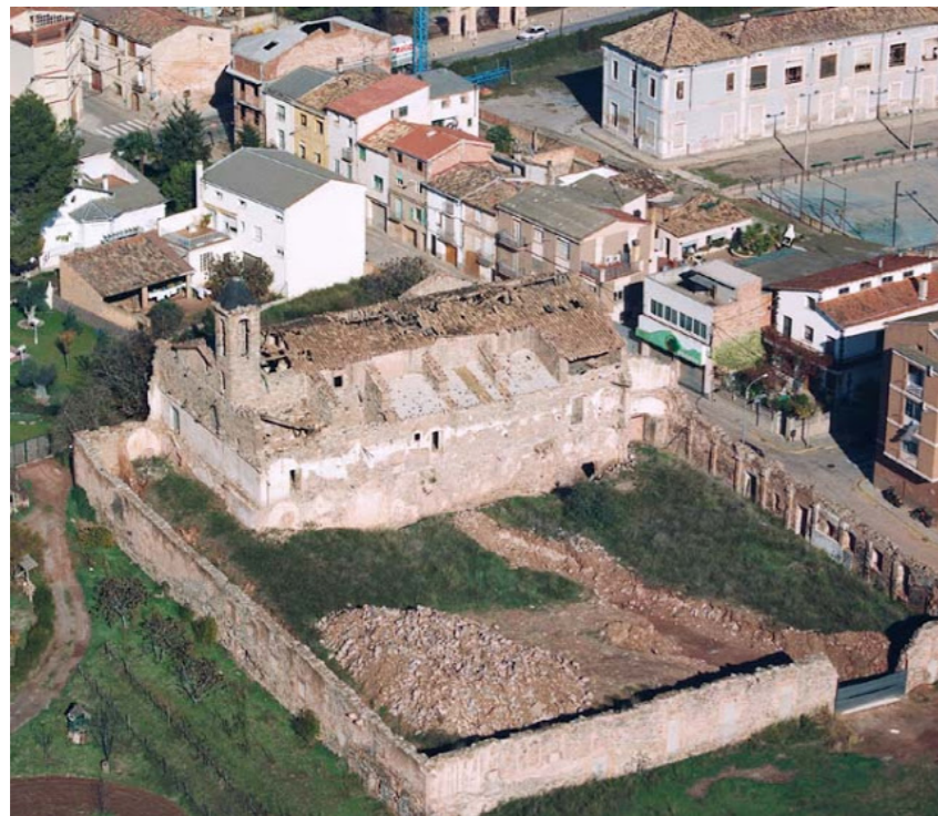
Figura 66. Estado original antes de la intervención Tomado de (plataformaarquitectura, 2015)
