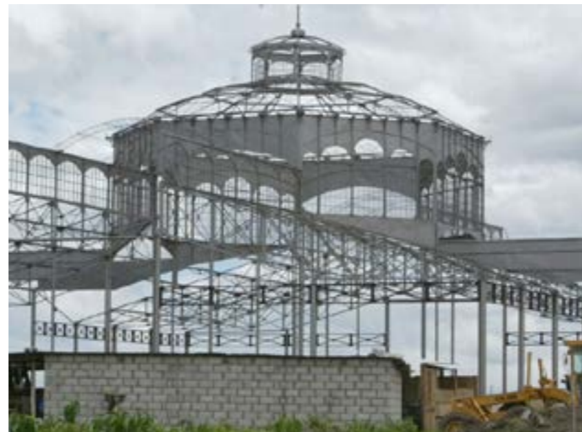
Figura 20: Estructura metálica del mercado Santa Clara reubicada en el C.C.Itchimbía. Tomada de Diario La Hora, 2004.
