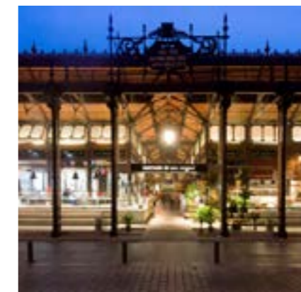
Figura 88: Fachada M. S. Miguel.
