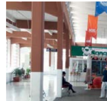
Figura 63: Estructura M.S. Francisco.
