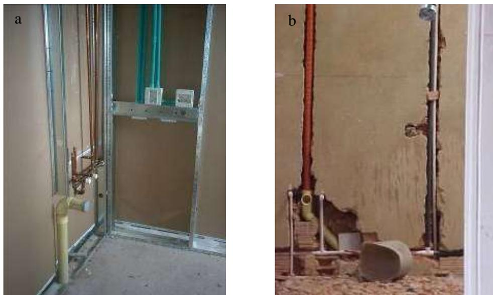
*Figura 13.* Instalaciones de servicios en muros internos
