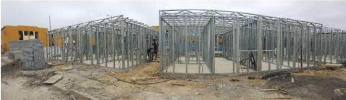
*Figura 10.* Estructura de acero galvanizado para viviendas en proceso de construcción
