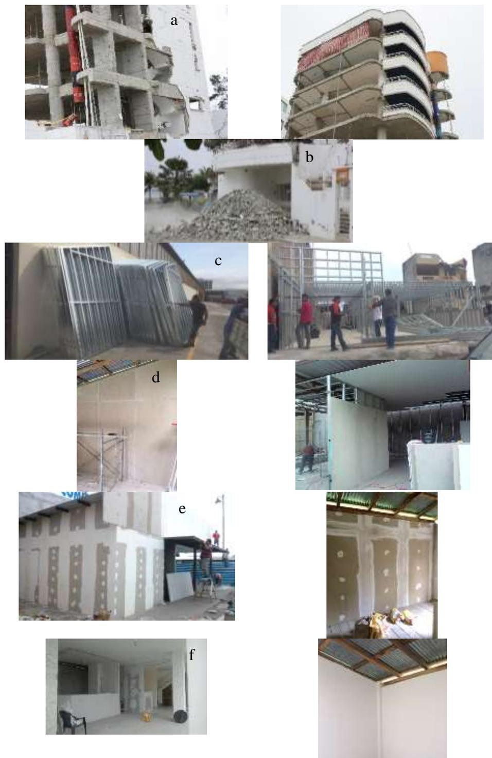
*Figura 21.* Fotografías de principales etapas de armado de muros SteelFraming
