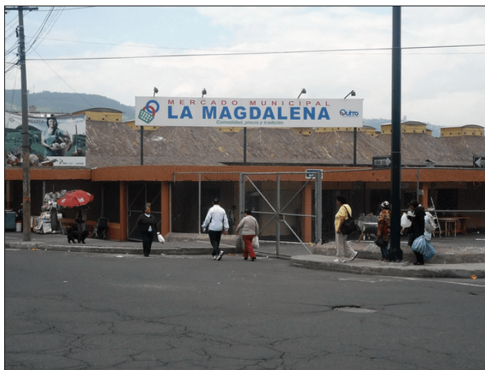
Figura 73: Fachada del Mercado de “La Magdalena”, 2017. Autoría propia
